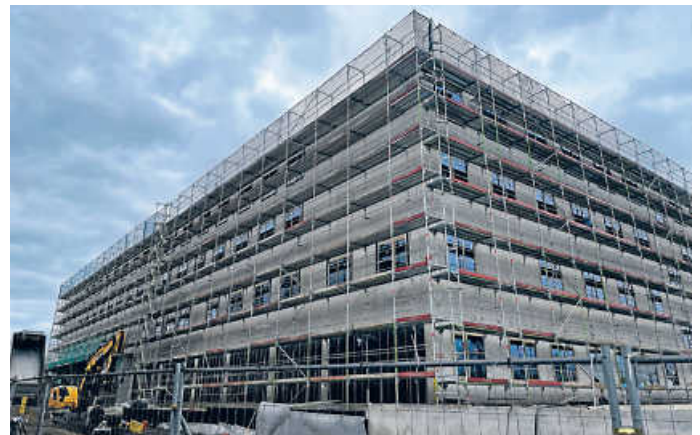
Der Rohbau des neuen Hohenloher Krankenhauses steht
