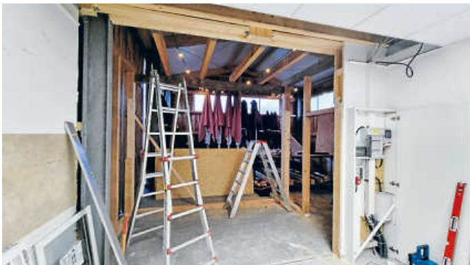
Einbau der neuen Küche für die Hohenloher Scheune Foto: Stadt Öhringen
