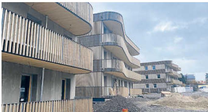
Die Baustelle liegt im Zeitplan: Öhringer Hoffnungshäuser im März 2023 Foto: Hoffnungsträger Stiftung
